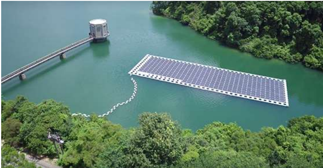
水塘上建設大型的浮式太陽能板發電 圖片來源：香港水務署網頁
